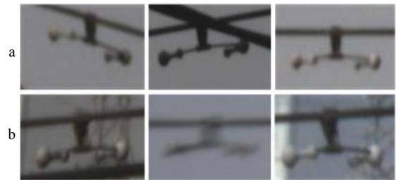
图10 判别错误与无法判别的防震锤示意
